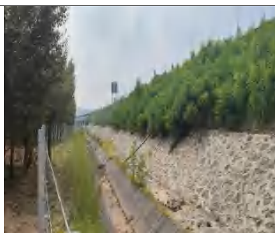
路基工程防治区边坡绿化
