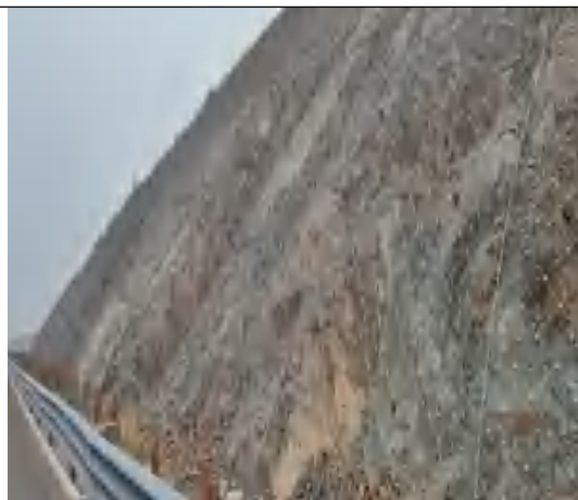
路基工程防治区边坡防护
