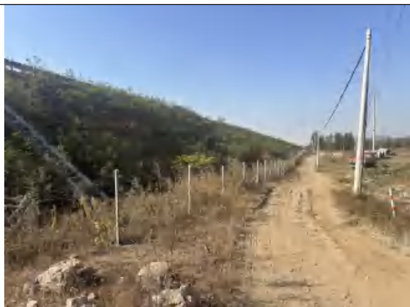
路基工程防治区边坡绿化
