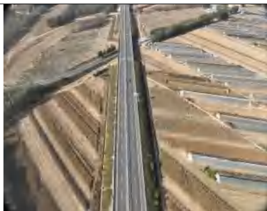
路基工程防治区边坡绿化
