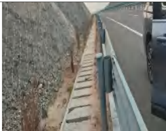
路基工程防治区排水工程
